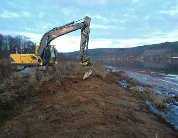
Framskrapning av öppen sand på igenväxt sandrevell, för att öka arealen lämplig livsmiljö för bl.a. strandsandjägare. Klarälven söder om Ekshärads flygfält. Foto: S-Å Berglind.
